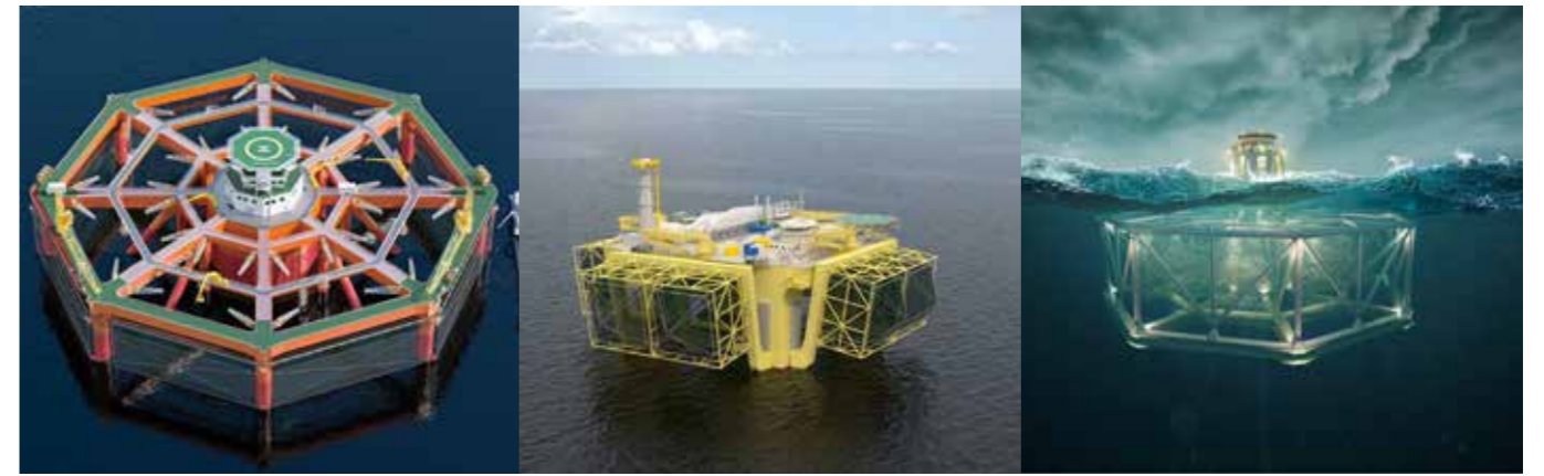
Figur 49: Tre ulike konstruksjoner som utvikles for å kunne drifte i det åpne hav. Fra venstre Smart Fish Farm, ViewPoint Seafarm og Aqualoop. Kilde: SalMar, ViewPoint, Aqualoop.
